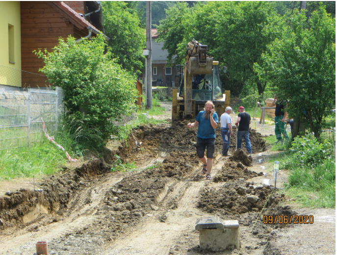
Oprava ulice v plném proudu.....
